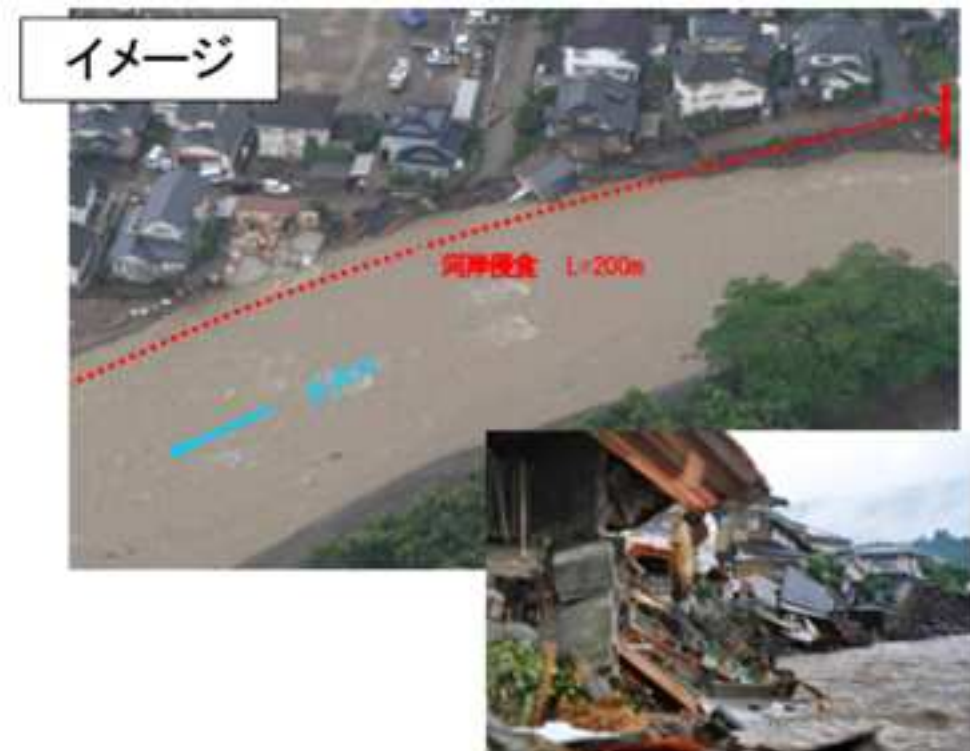
河岸侵食により家屋倒壊した状況
