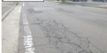
路面の亀裂
