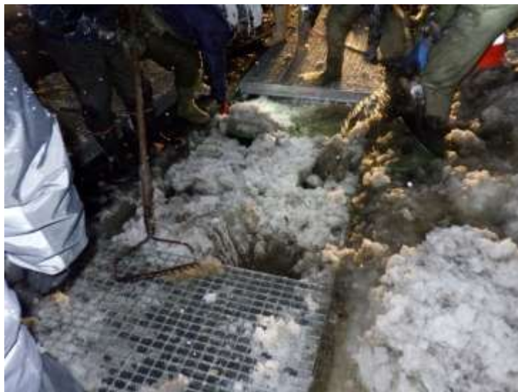
※復旧作業状況（1/25深夜）
